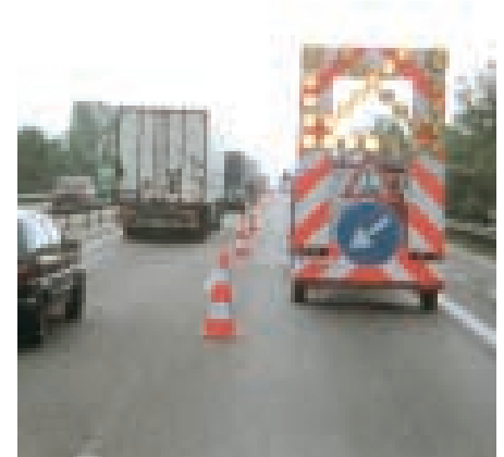
VSA bei der Absicherung.
